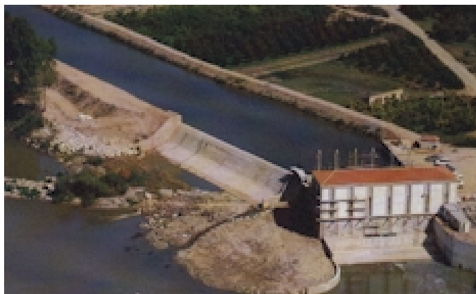
Fig. 11.2 Minicentral hidroeléctrica fluyente
