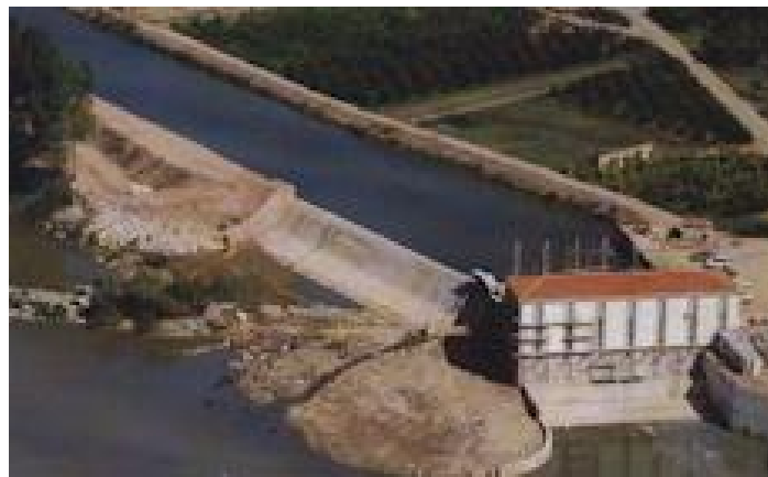
Fig. 10.19 Minicentral hidroeléctrica fluyente
